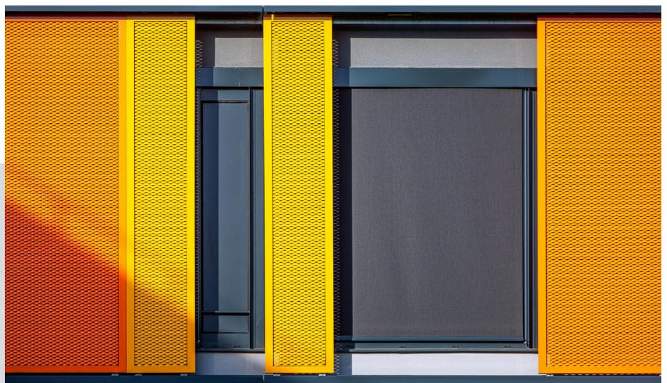
Im Außenbereich wurden mehr als **640 motorisierte kabelgebundene Rollos von ATEs** aus dem **Gewebe Satiné 5500 in der Farbe 3030 Charcoal** von Mermet installiert. Mit diesen Vertikaljalousien:
